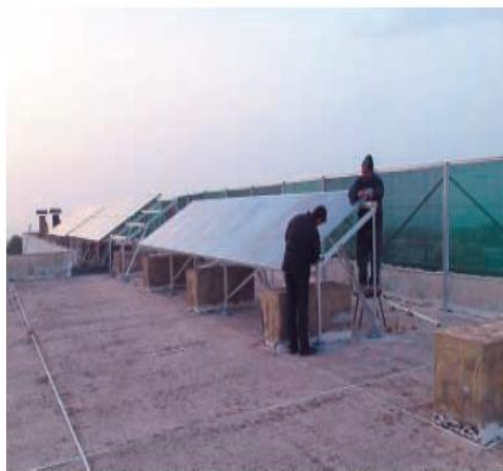
Στιγμιότυπο από την εγκατάσταση των φωτοβοληταϊκών πλαισίων
