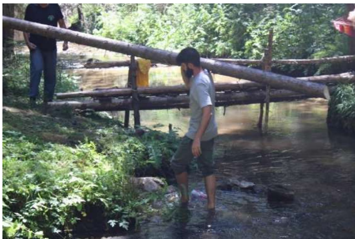
Εικόνα 21 Συλλογή κορμών για ξυλοκατασκευές
