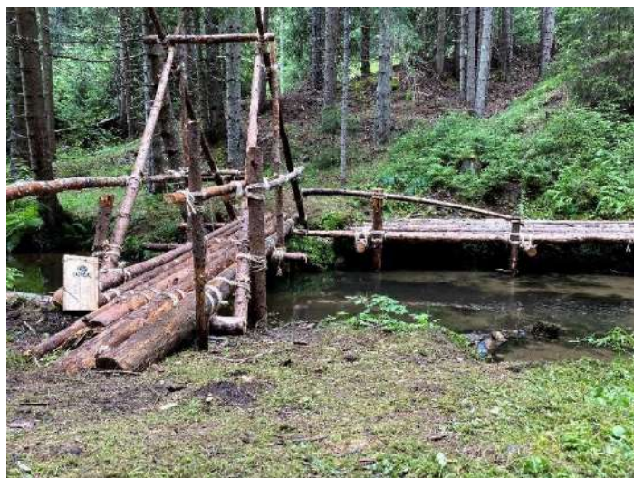
Εικόνα 30 Τελική μορφή γέφυρας και προβλήτας
