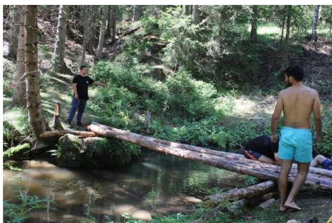
Εικόνα 24 Τοποθέτηση πατώματος της γέφυρας
