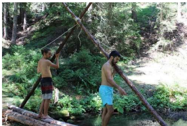
Εικόνα 27 Τοποθέτηση πλάγιου τμήματος γέφυρας (στήριξη Λ)
