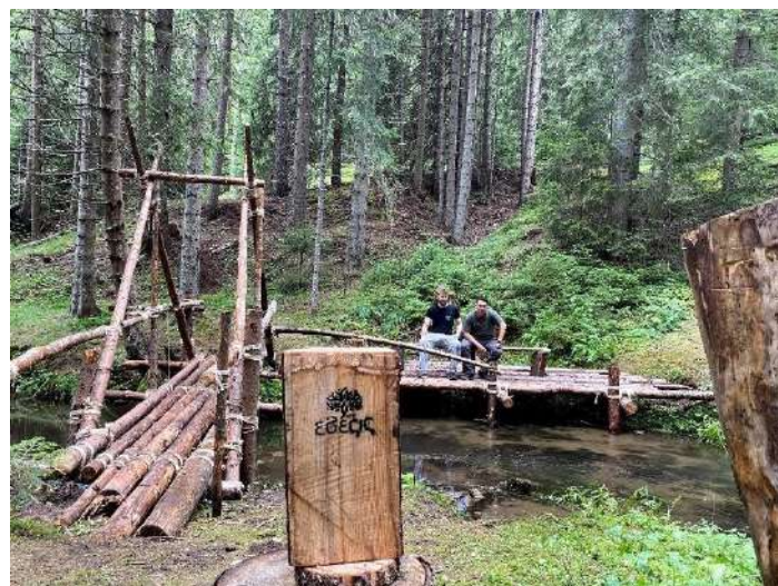
Εικόνα 29 Τελική μορφή γέφυρας και προβλήτας
