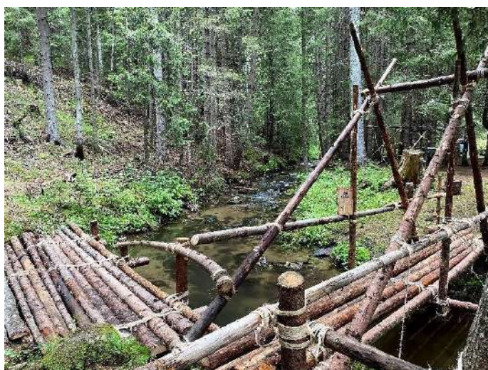
Εικόνα 28 Τελική μορφή γέφυρας και προβλήτας
