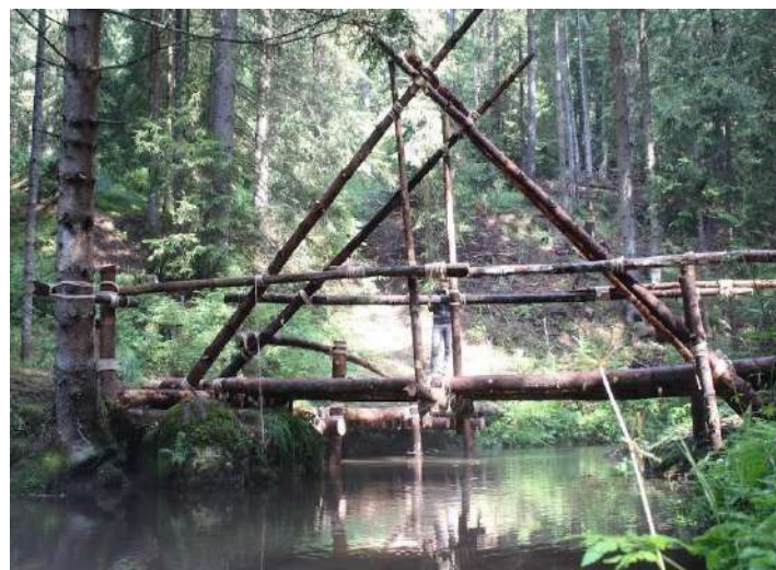
Εικόνα 31 Πλάγια όψη γέφυρας
