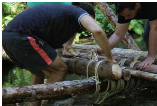
Εικόνα 25 Σύνδεση των κορμών με σχοινί
